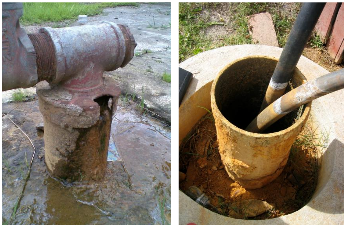
Figure 4.60. Exemple de la précipitation du fer dans l'aquifère. Cas des forages Acosta Soberón (C151) et El Nacional (M302)
